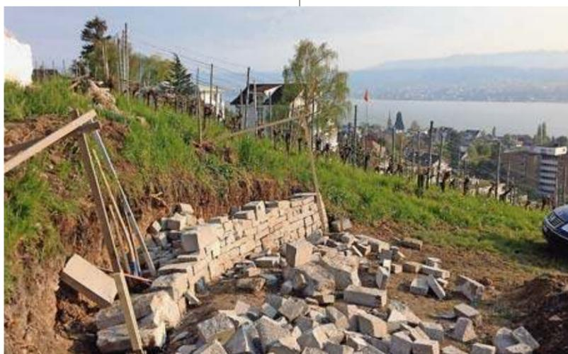
Ende April wurde das Fundament ausgehoben, danach wurde Stein um Stein von Hand an der richtigen Stelle platziert.
